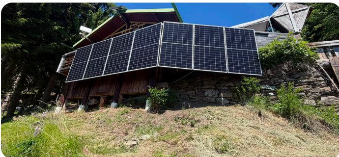
STEIL AUFGESTÄNDERTE MODULE AN DER HÜTTE AM ZETTERSFELD • SCHNEE RUTSCHT AB, WINTERSONNE TRIFFT FAST SENKRECHT
