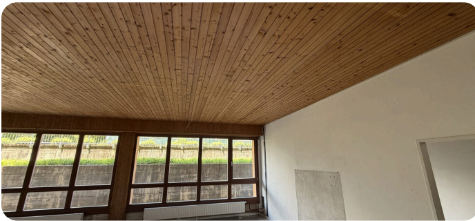
VORHER • ALTE HOLZDECKE OHNE MODERNE BELEUCHTUNG (ELEKTRO-UMBAU GAILTAL)
